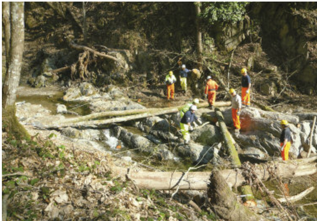
Uno dei cantieri della nostra Protezione Civile a Monterosso, in Liguria, nel post-alluvione.
